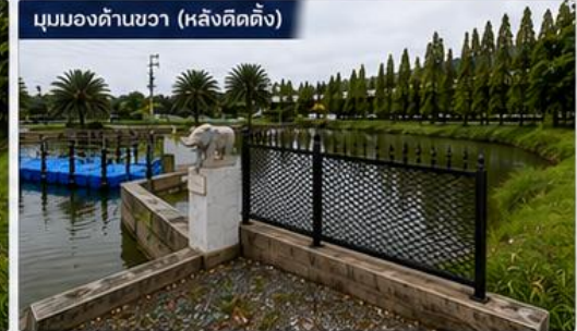
มุมมองด้านขวา (หลังติดตั้ง)
